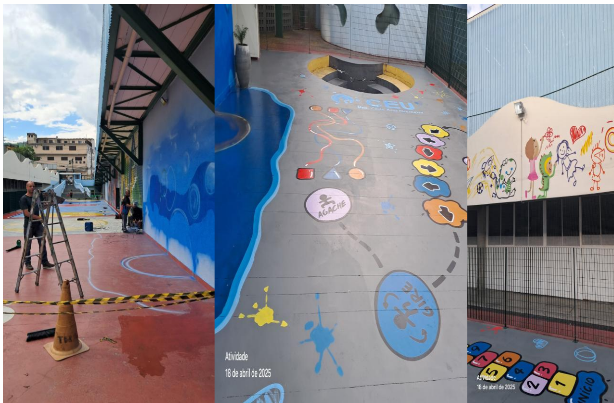
Pintura do pátio e da fachada
